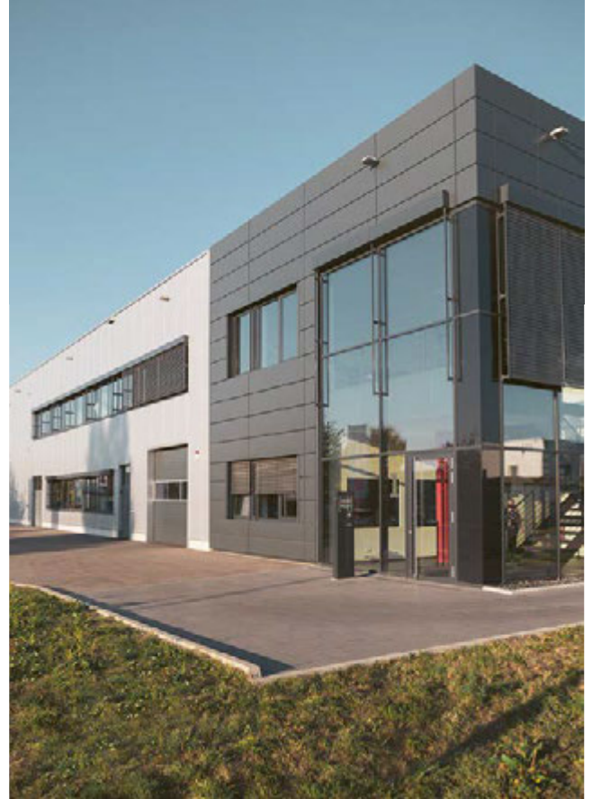
Oben Ein starkes Wachstum erfordert mehr Mitarbeiter und neue Produktionsanlagen. 2016 wird der Hightech-Neubau in Winnenden-Hertmannsweiler bezogen.
